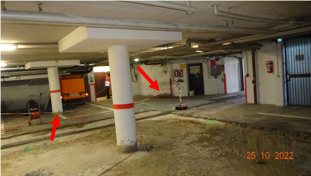
Foto 03: Farbablösungen an Wand und Stütze
