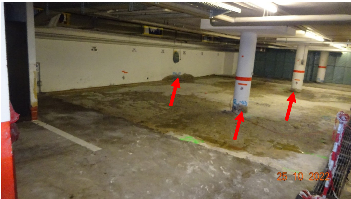
Foto 02: Farbablösungen an Stütze und Wand
