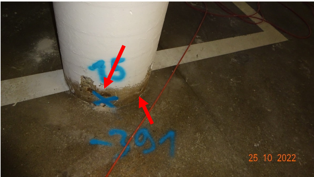
Foto 04: Farbablösungen und Oberflächenrost an Stütze
