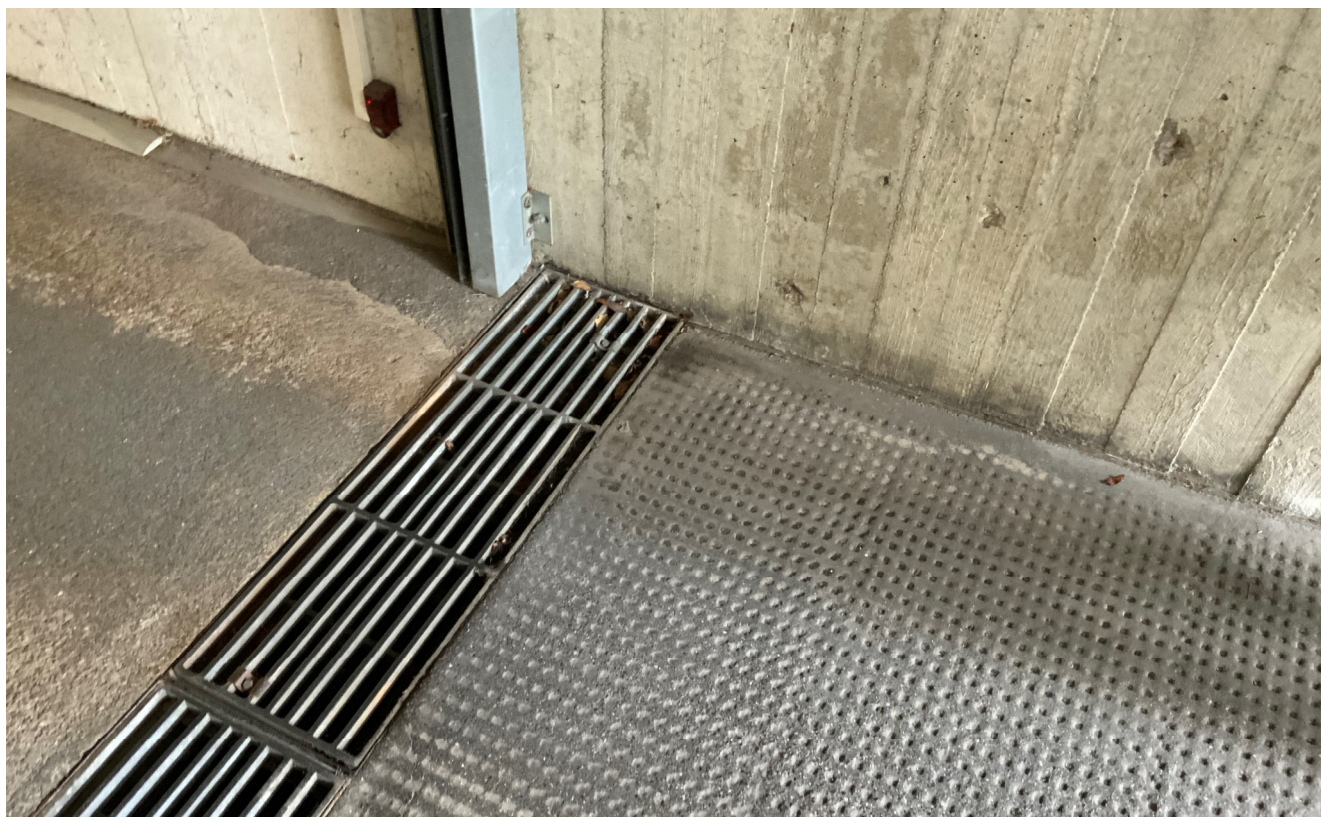
Abb. 14: Entwässerungsrinne Rampenfuß.
