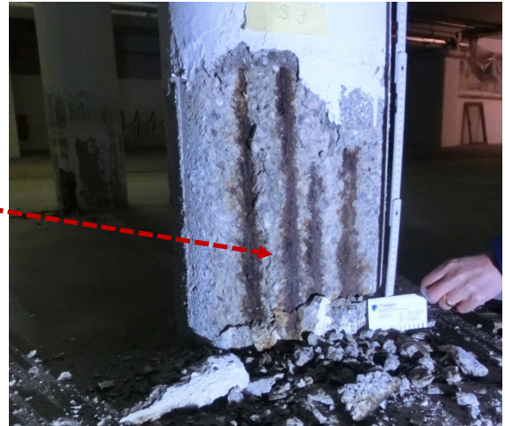
Abb. 33: Charakteristisches Schadensbild, Betonabplatzung durch Bewehrungskorrosion.
