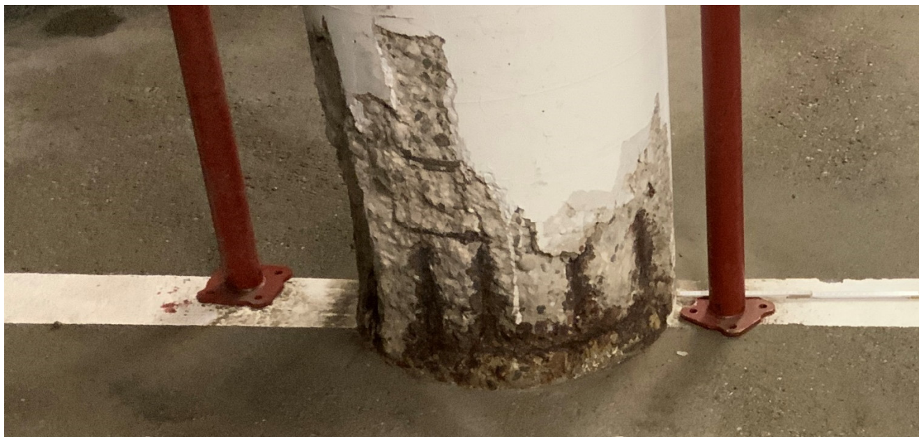
Abb. 9: Betonabplatzungen, starke Korrosionsschäden, Sockelbereiche Stb.-Rundstütze. Signifikante Querschnittsverluste an der tragenden Bewehrung. Die Standsicherheit ist gefährdet.
