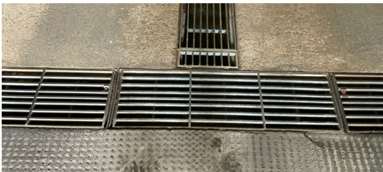
Abb. 15: Anschluss Entwässerungsrinne Rampe.
