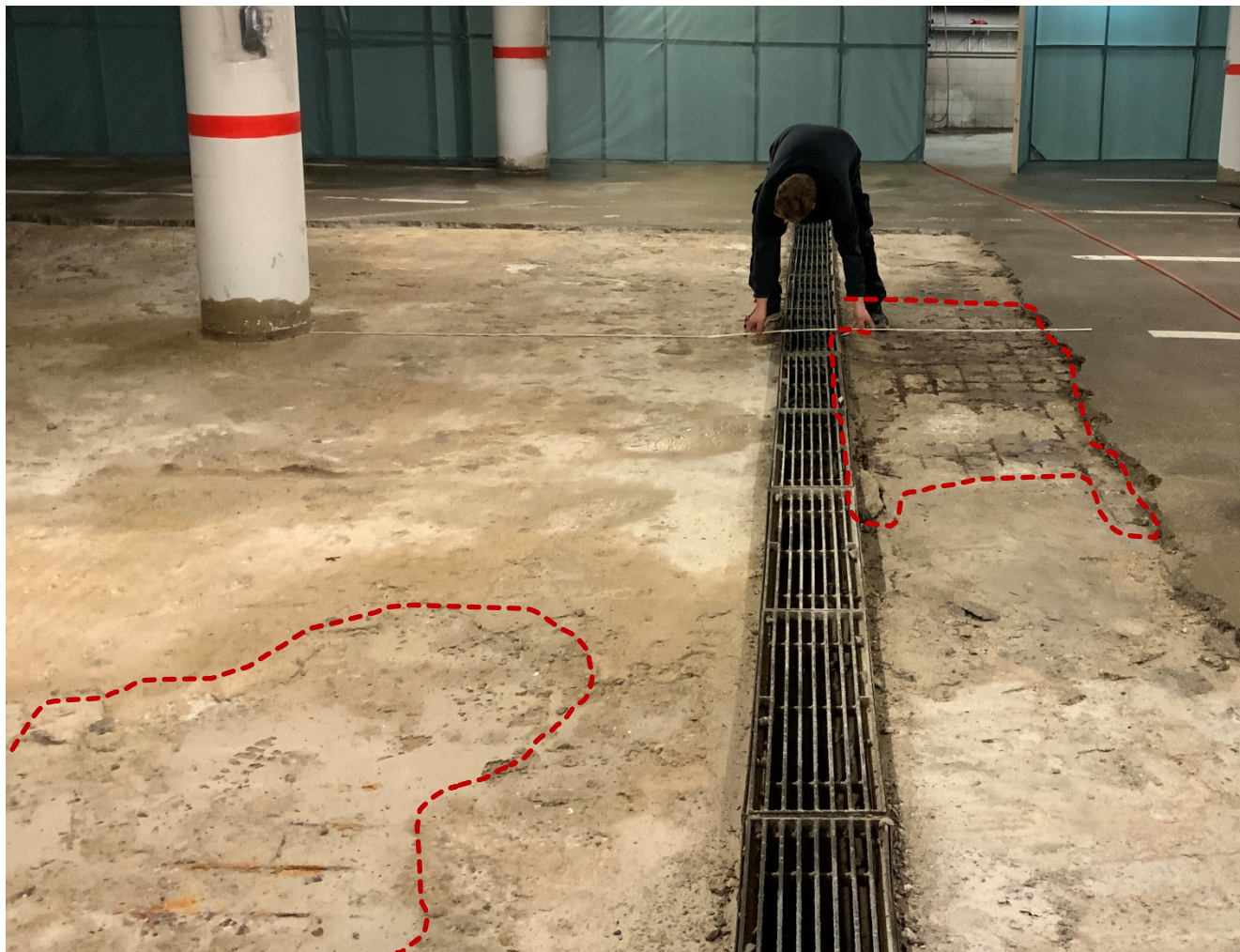
Abb. 12: Freiliegende, korrodierte Oberbewehrung der Bodenplatte.
