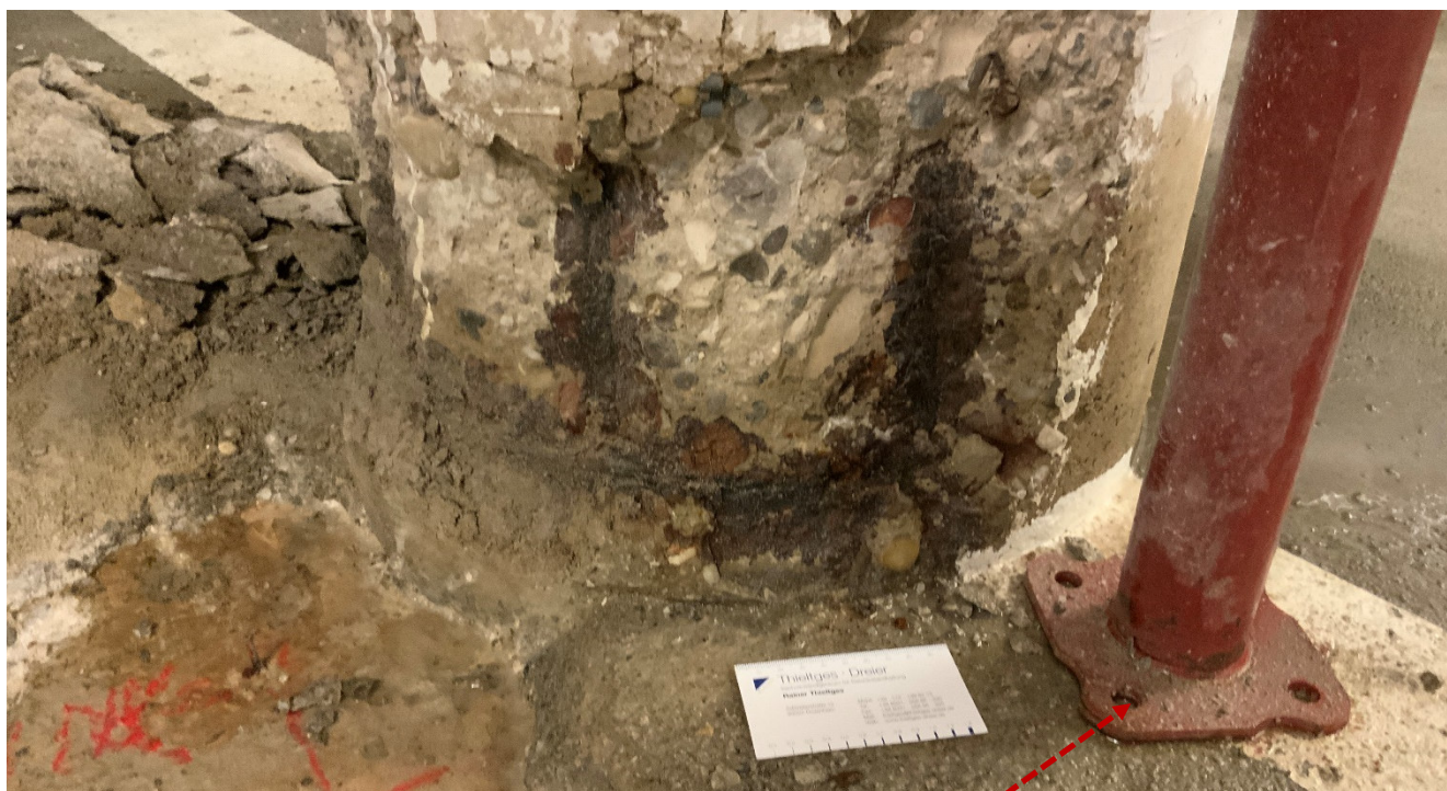
Abb. 10: Stützenbewehrung mit hohen Abrostungsraten.
