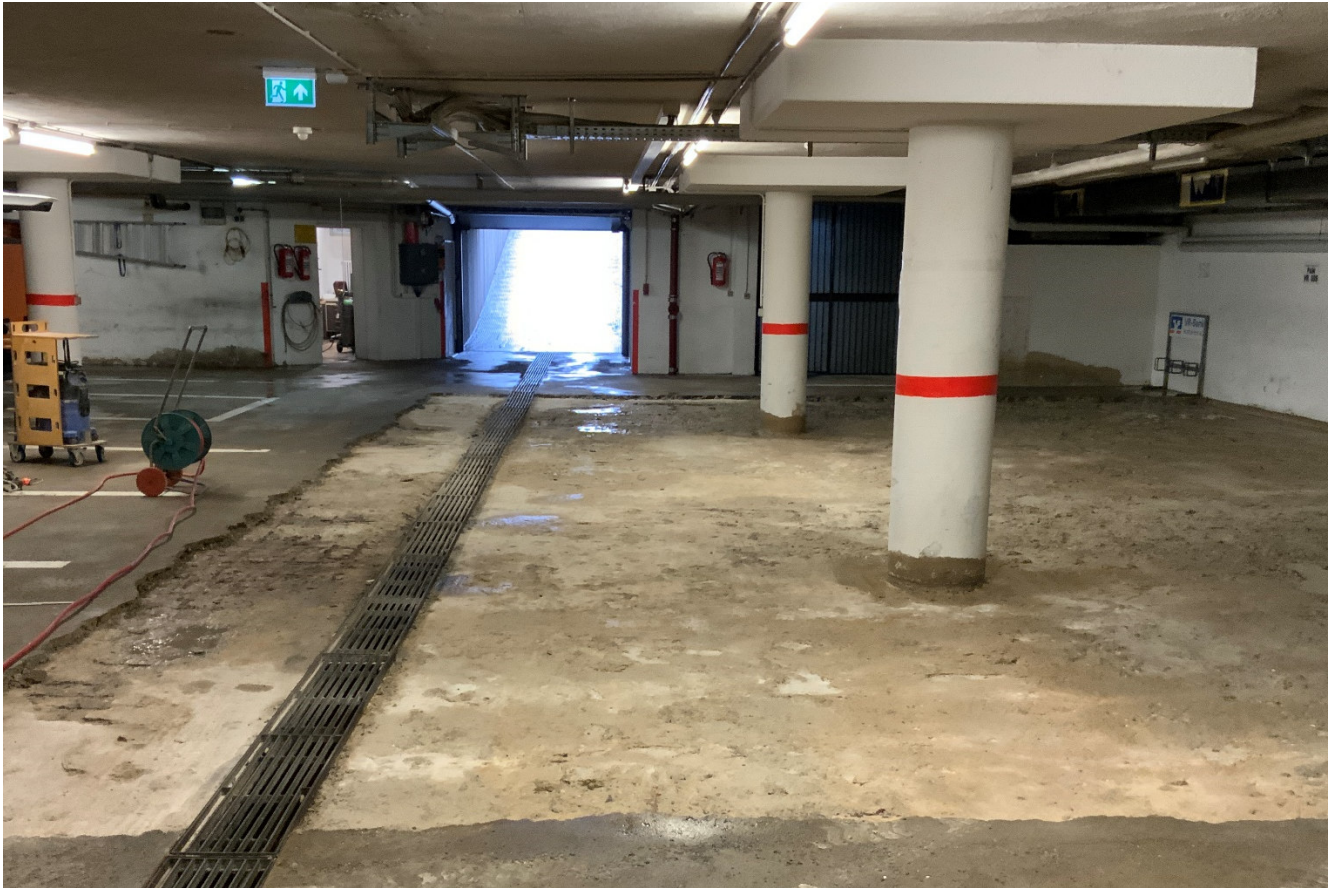
Abb. 7: Blick auf die in Teilbereichen freigelegte Bodenplatte.
