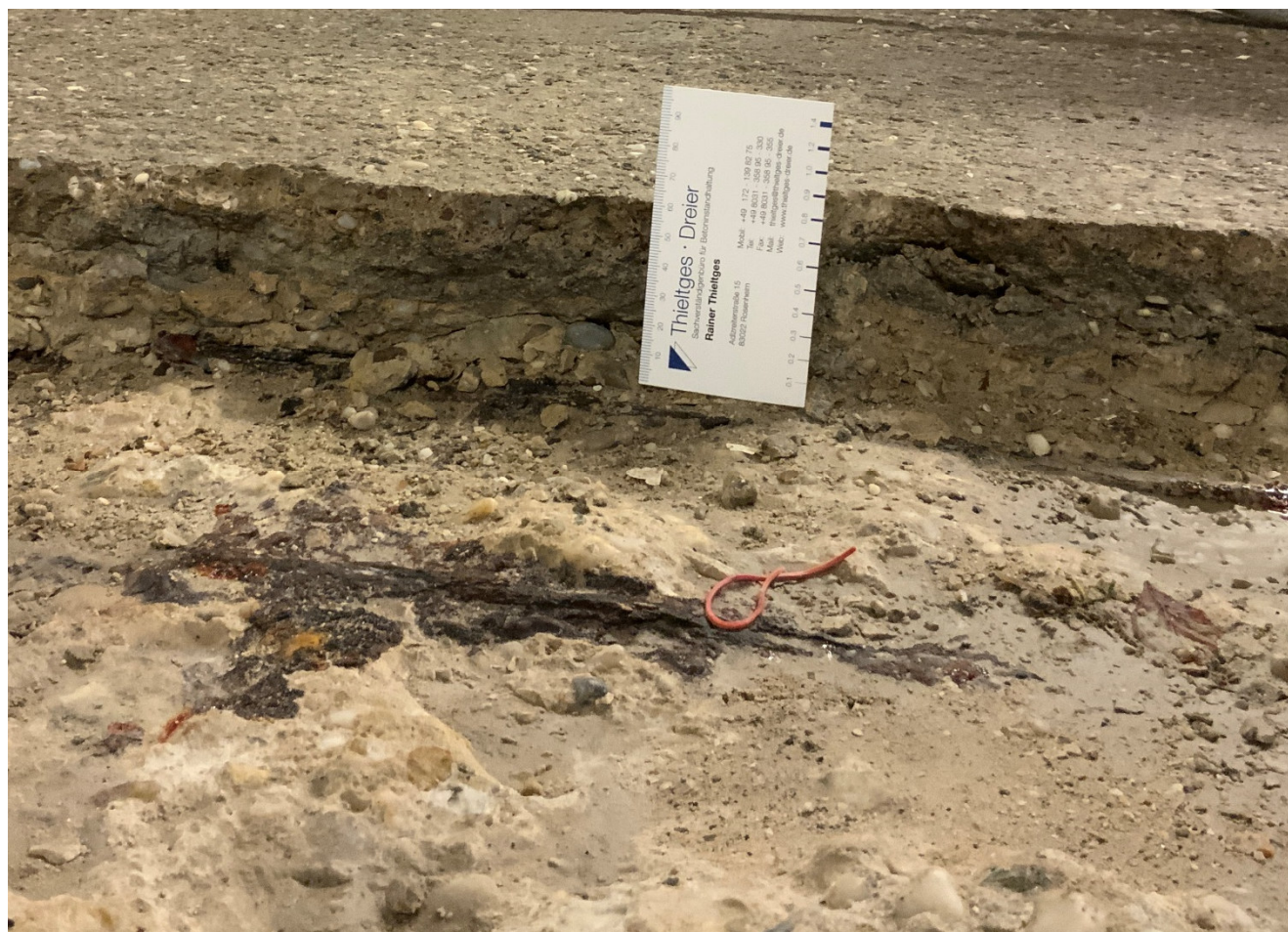
Abb. 11: Blick auf den Verbundestrich und die Oberseite der Stb.-Bodenplatte.
