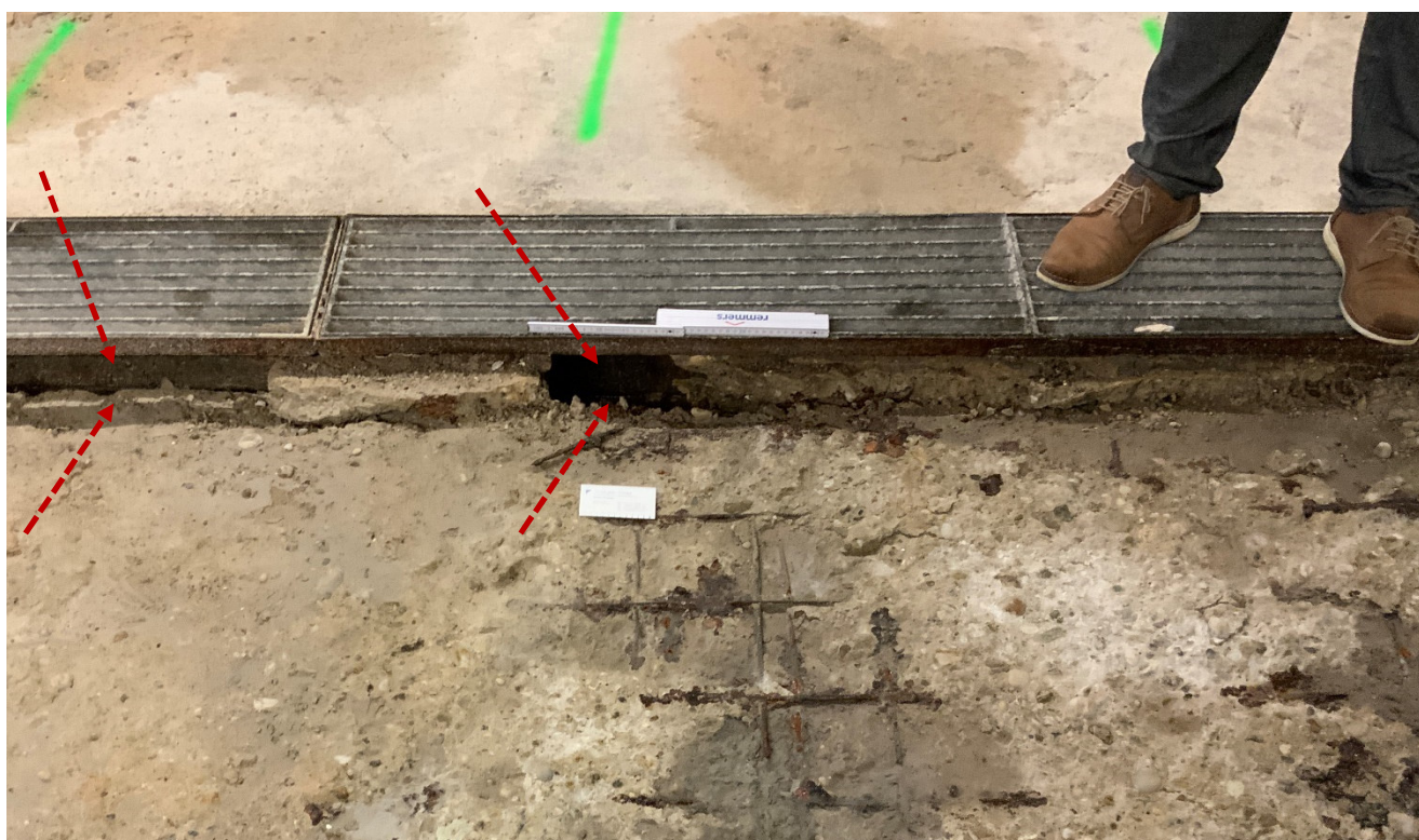
Abb. 13: Entwässerungsrinne aufgesetzt.
