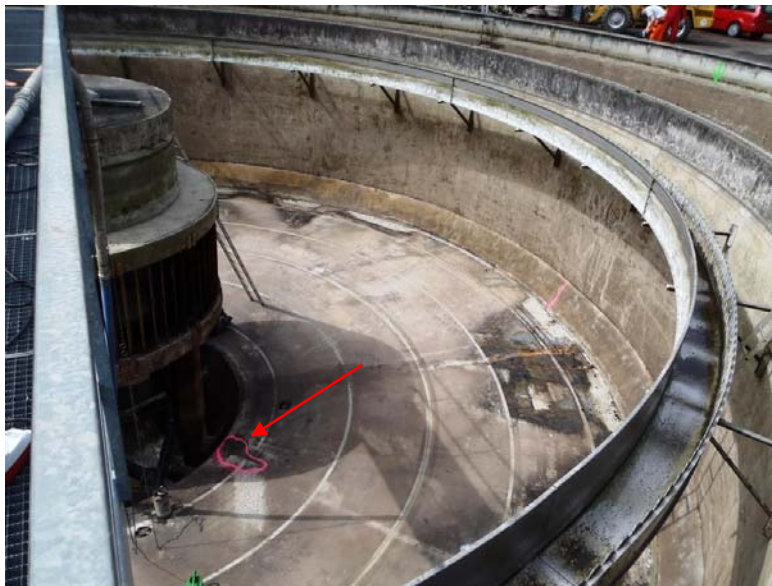
Bild B-NKB 5 Bereich mit einem Höhenversatz im Bereich des Bodens
