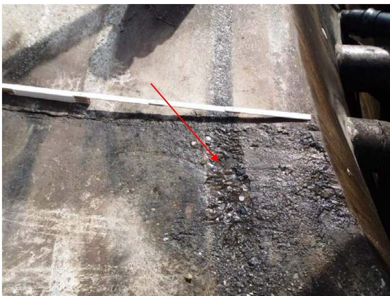
Bild B-NKB 6 Detail: Bereich mit Höhenversatz (siehe Bild oben)
