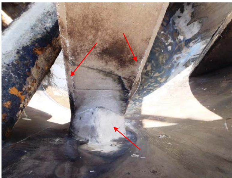
Bild K-NKB 3 Kiesnester im Eckbereich der Stützen; Schutz im Durchdringungsbereich der Stütze und des Schlamtrichterwand
