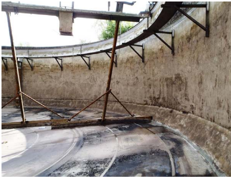
Bild B-NKB 4 Räumerradspuren im Bereich des Bodens des NKB
