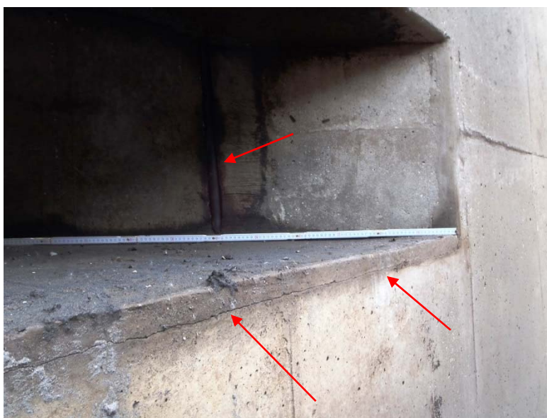
Bild W-BB 3 Zulaufschacht – Abdichtung sichtbar; Risse im unteren Bereich der Aufbetonschicht
