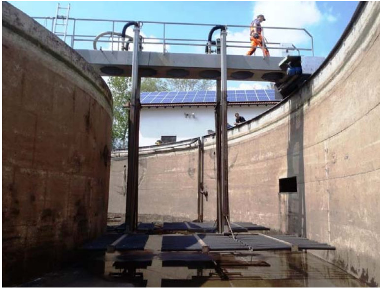
Bild W-BB 1 Innen und Außenwand des Belebungsbeckens
