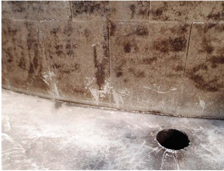
Bild B-BB 4 Dükereinlauf in der Bodenplatte im nördlichen Bereich des Belebungsbeckens
