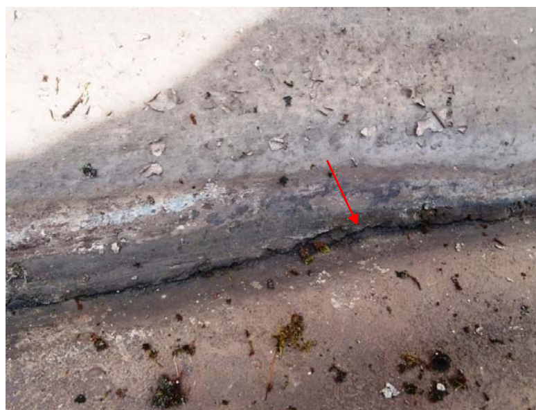
Bild B-NKB 3 Umlaufender Riss unterhalb des betonkeil im Bereich der Trennwand unten
