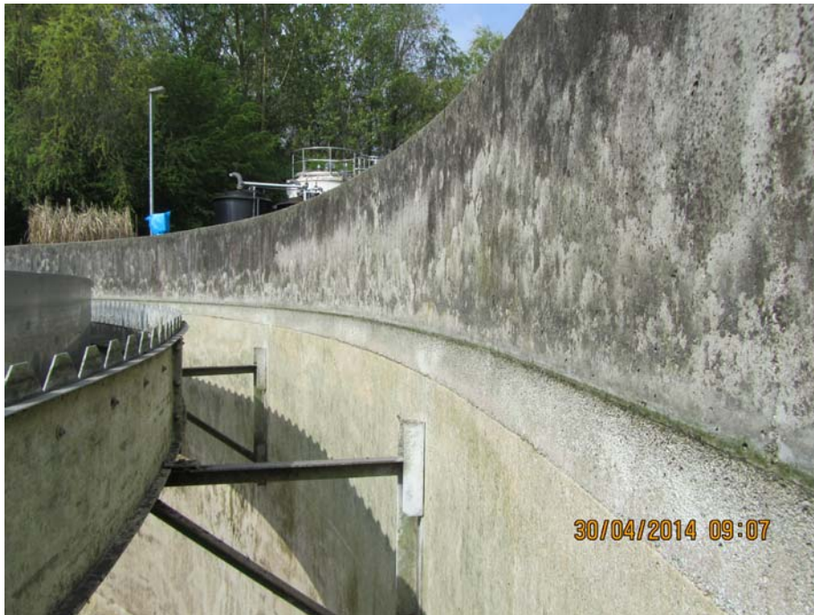
Wasserwechselzone Nachklärung 2
