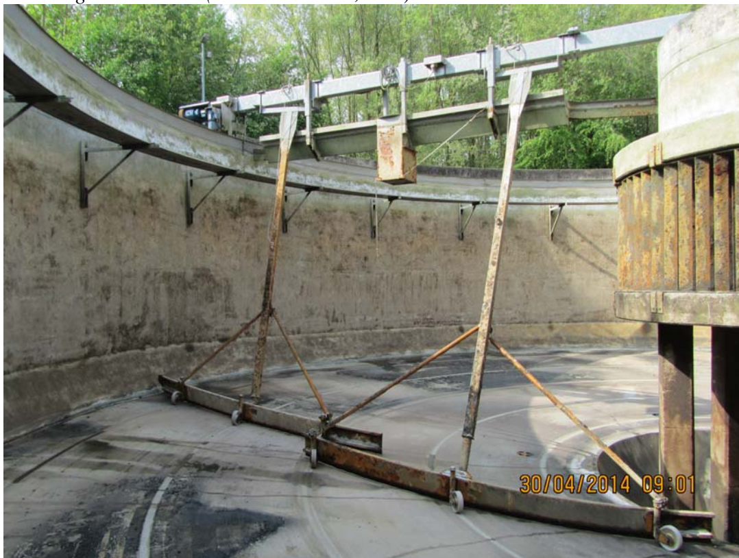
innenliegendes Nachklärbecken mit Schlammtrichter und Königsstuhl auf Stützen (entfällt)
