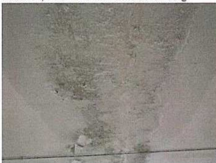
RISSE MIT DURCHFEUCHTUNG_DECKE
