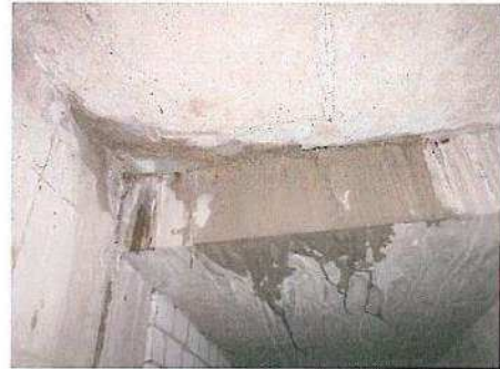
UNDICHTE FUGE IM ENTLÜFTUNGSTUNNEL ACHSE F
