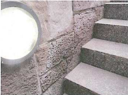
VORSATZSCHALE DURCHFEUCHTET
