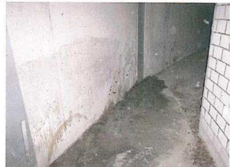
LÜFTUNGSGANG FEUCHTE STELLE
