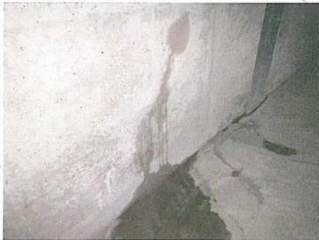
FEUCHTER RISS AUßENWAND
