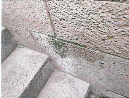
VORSATZSCHALE DURCHFEUCHTET
