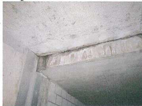
BAUWERKSFUGE LÜFTUNGSKANAL
