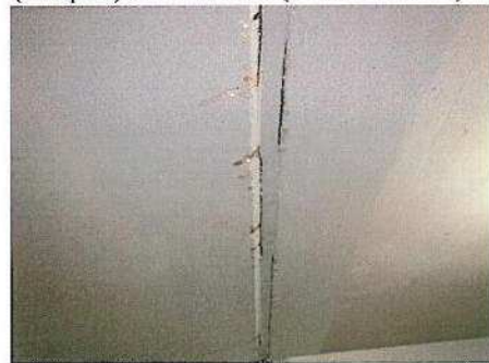
DEHNUNGSFUGE FEUCHT ZWISCHEN TH UND PARKDECK
