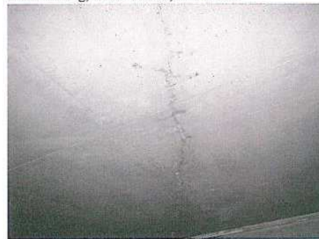
RISS MIT AUSSINTERUNGEN
