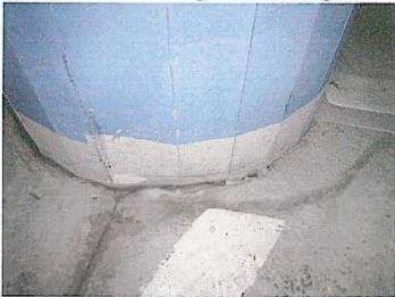
FUGEN IM BEREICH STÜTZENFÜßE OFFEN
