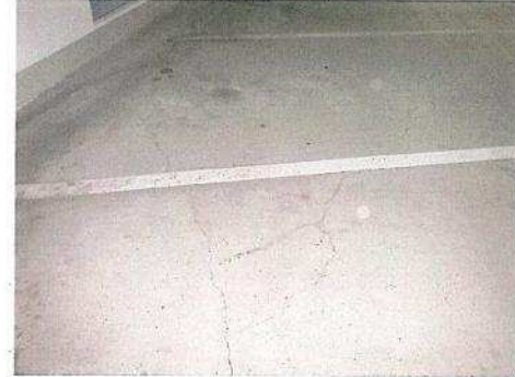
RISS BODENPLATTE
