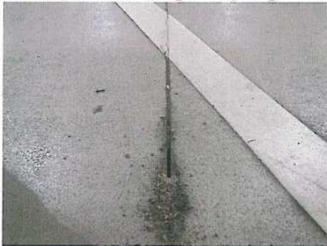
OFFENE FUGEN BODENPLATTE
