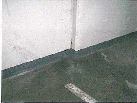
DURCHDRÜCKENDES WASSER_BODENPLATTE
