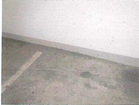
GEFÄLLEKEIL BODENPLATTE
