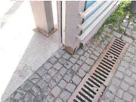
STAHLKONSTRUKTION ANGEROSTET
