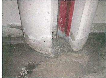
ABPLATZUNG_CHLORIDE_BRANDSCHUTZTOR
