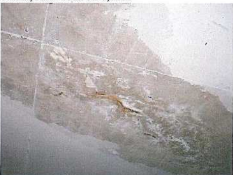
FEUCHTER RISS DECKE
