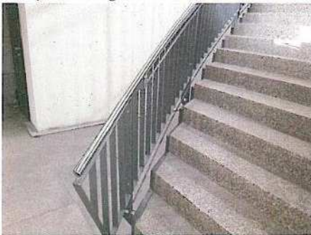
LOCKERE GELÄNDERVERANKERUNG
