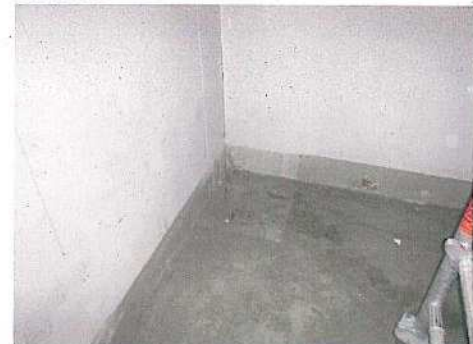
FEUCHTE STELLE BODENPLATTE
