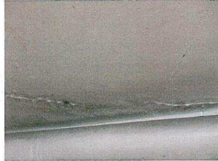
RISS MIT AUSSINTERUNG_DECKE
