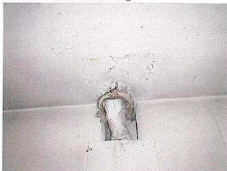
ENTWÄSSERUNGSRÖHR ANGEROSTET
