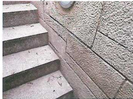
VORSATZSCHALE DURCHFEUCHTET
