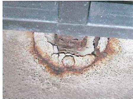
ANGEROSTETE PFOSTENFÜßE DER ABSTURZSICHERUNG
