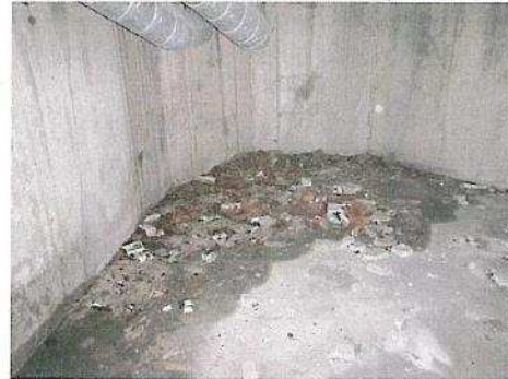
SCHMUTZABLAGERUNG LÜFTUNGSSCHACHT
