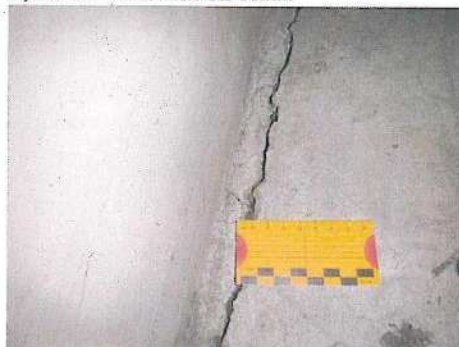
RISS BODENPLATTE
