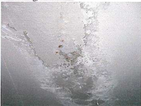
RISS MIT AUSSINTERUNG DECKE
