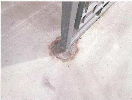
PFOSTENFÜßE ANGEROSTET
