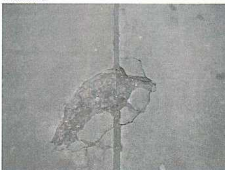
AUSBRÜCHE IN BODENPLATTE
