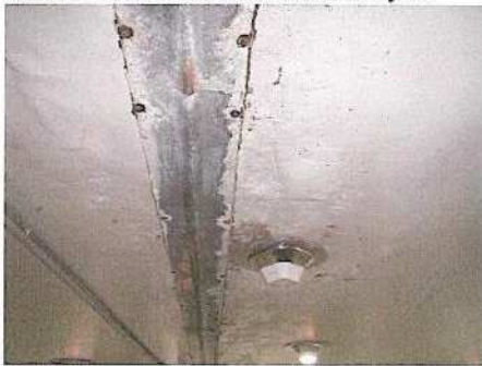
FUGE DECKE DURCHFEUCHTET
