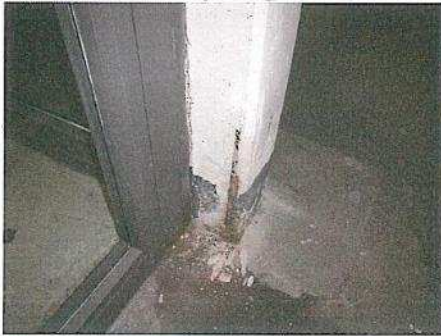
ABPLATZUNG MIT FREILIEGENDER BEWEHRUNG
