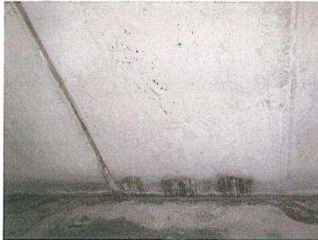
DURCHDRÜCKENDES WASSER LÜFTUNGSZENTRALE
