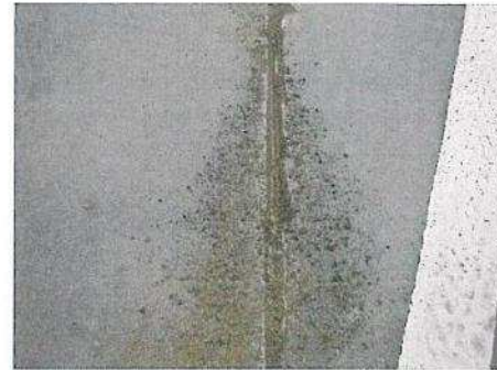
FUGE OFFEN BODENPLATTE
