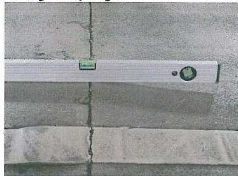
UNEVENHEIT BODENPLATTE
