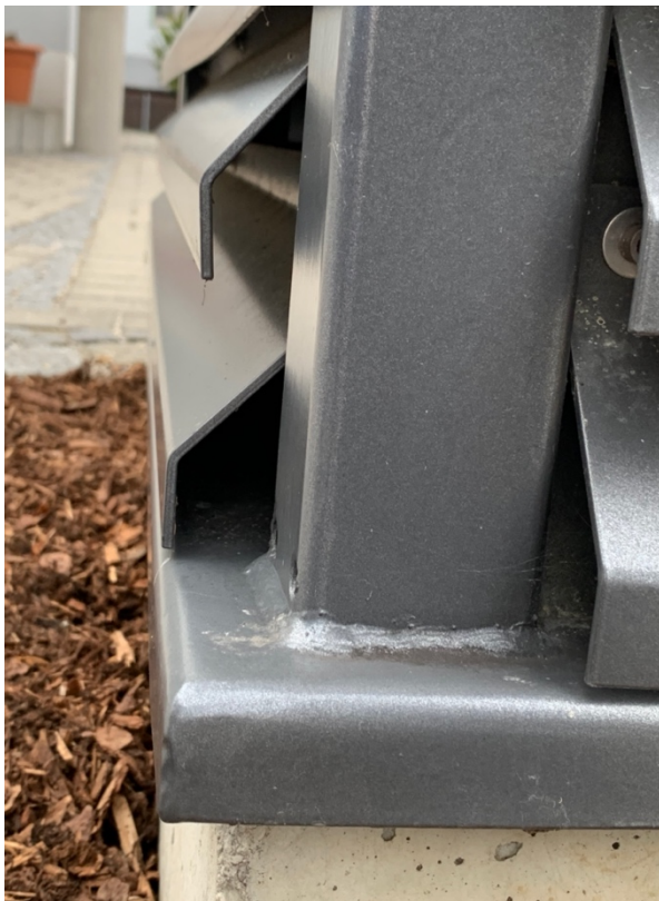
Abb. 16: Bsp.: Unterkonstruktion mit Tropfkante
