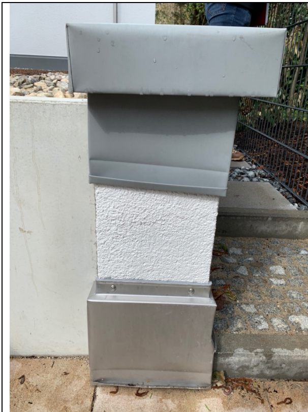
Abb. 19: Mangelhaft installierte Verblendung
