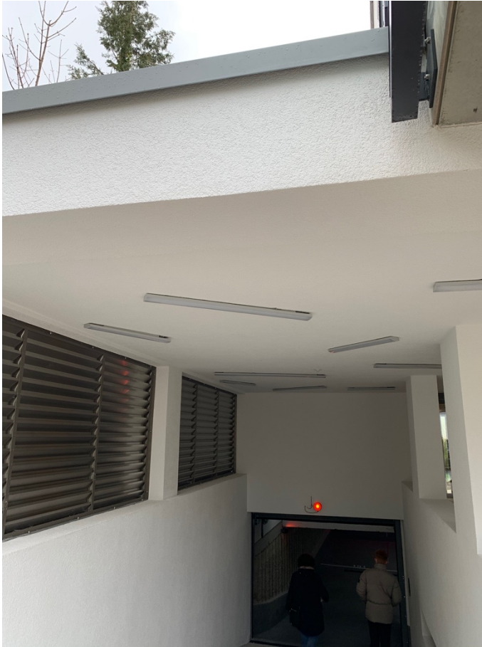
Abb. 2: Blick auf einen Teil der mangelhaft montierten Beleuchtungskörper
