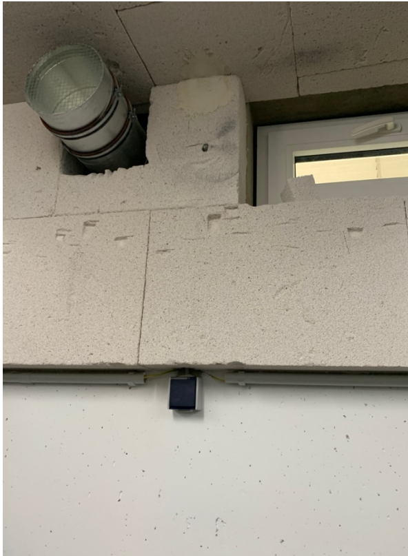
Abb. 44: Mangelhafte Innendämmung
