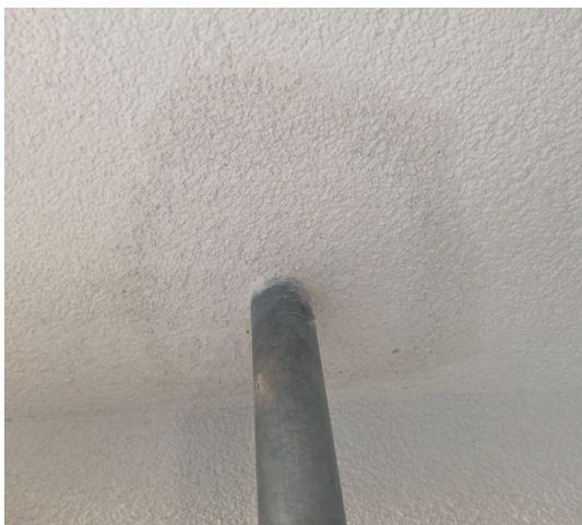
Abb. 24: Evtl. Wasserschaden / optischer Mangel
