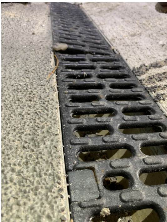
Abb. 10: Fehlende Dehnungsfuge. Gitter passt nicht mehr
