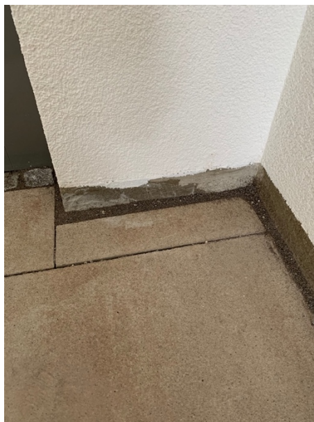
Abb. 7: Sockel nicht fachmännisch gemalert. Feuchte sichtbar
