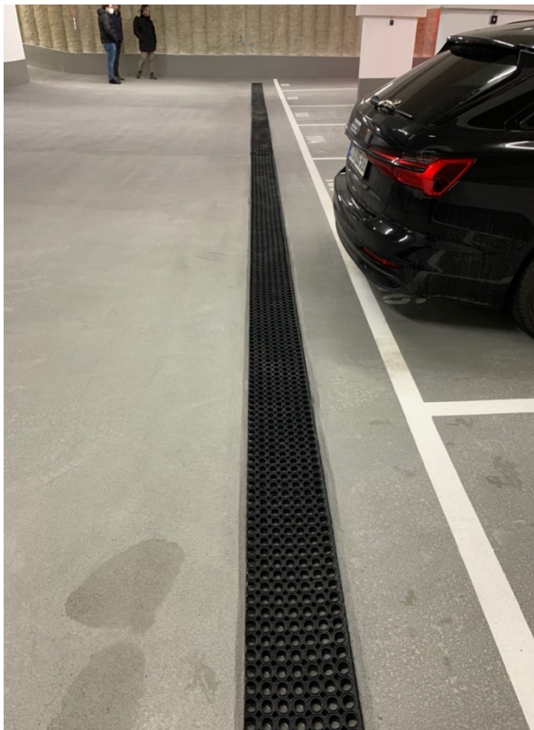
Abb. 36: Verdunstungsrinne mit Gummimatten
