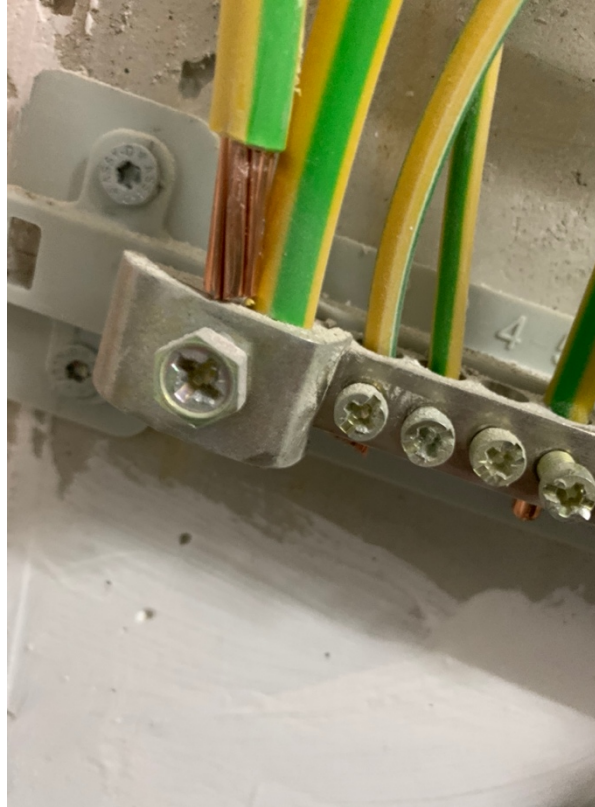
Abb. 43: PE-Leiter mangelhaft montiert
