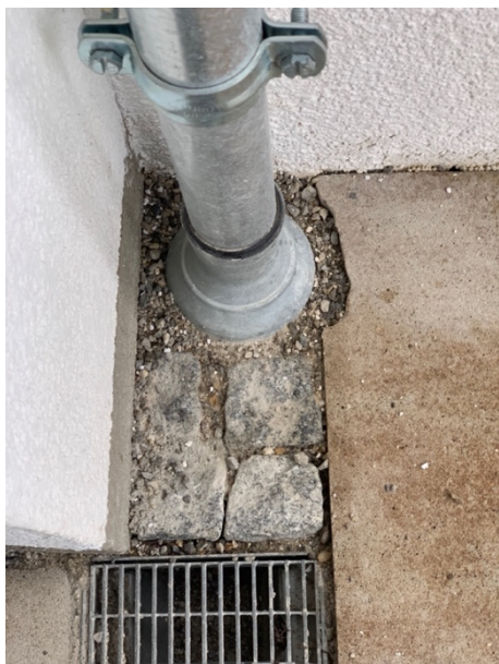
Abb. 6: Aussparung des Pflasters unfachmännisch
