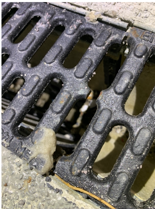
Abb. 11: Fehlende Dehnungsfuge. Gitter klemmt
