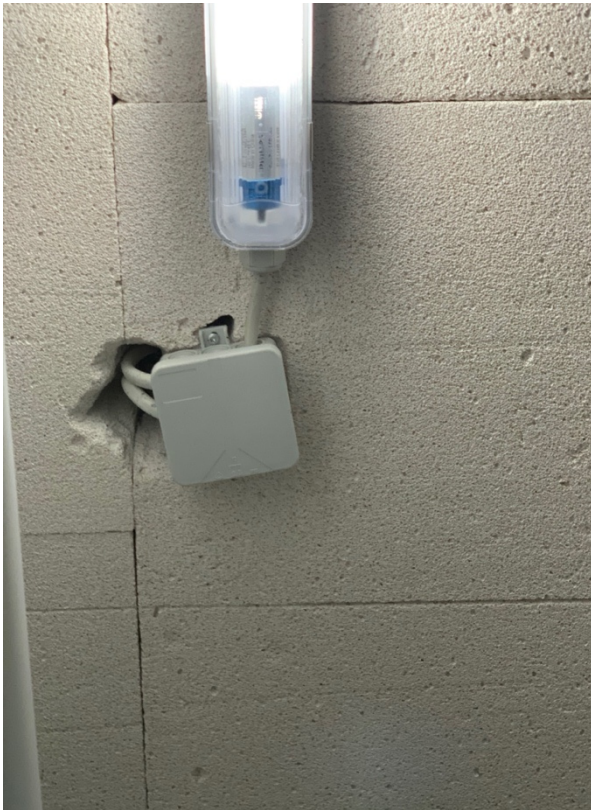
Abb. 40: Mangelhaft installierte Verteilerdose
