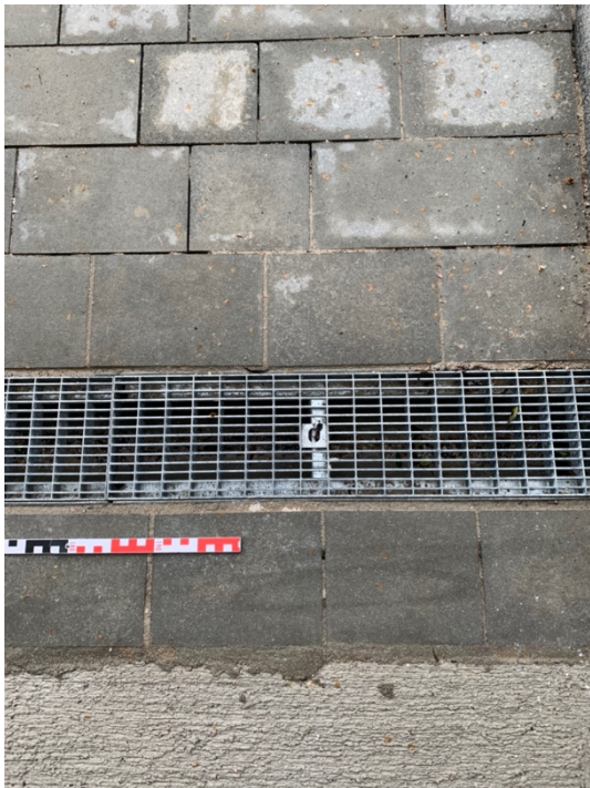
Abb. 8: Fixierung des Gitters nicht möglich
