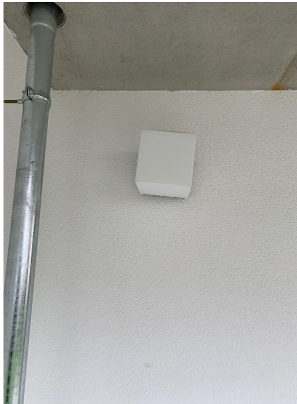
Abb. 29: Weitere mangelhaft fixierte Außenleuchte
