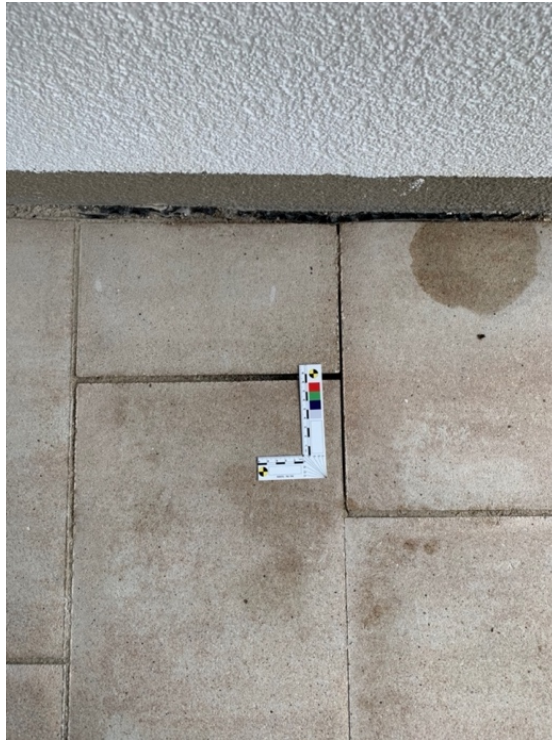
Abb. 5: Mangelhaftes Verlegebild. Gefahr von Spannungsrissen
