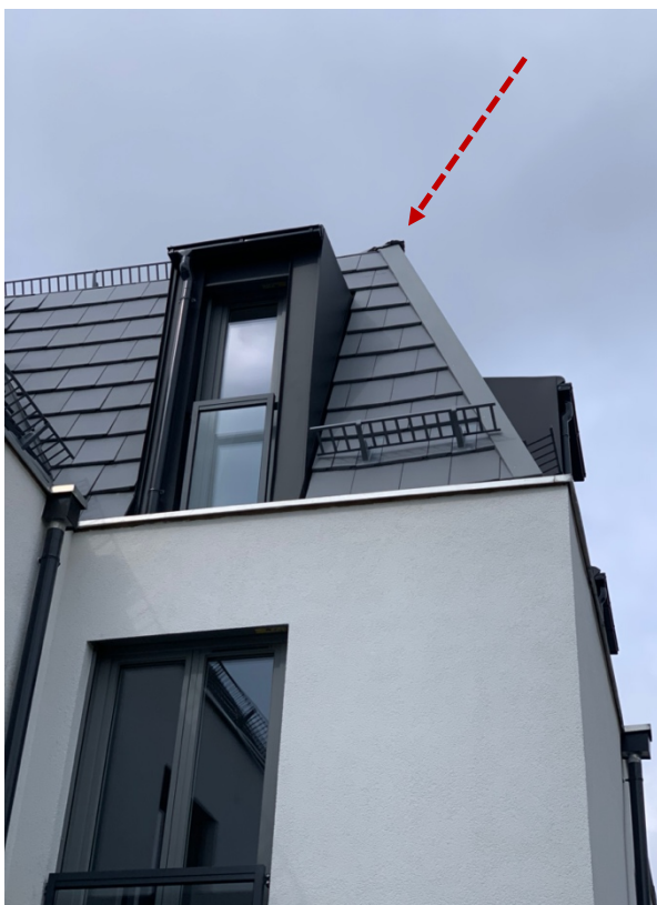
Abb. 26: Mind. ein Firstziegel fehlt
