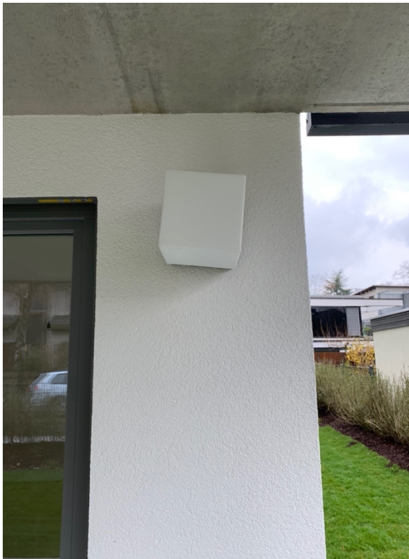
Abb. 28: Mangelhaft fixierte Außenleuchte
