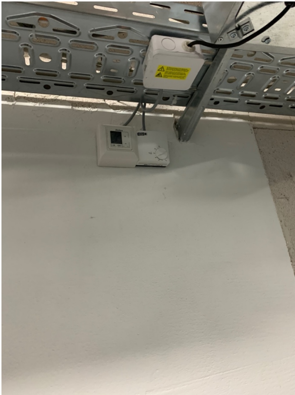
Abb. 35: Steuerung derzeit frei zugänglich
