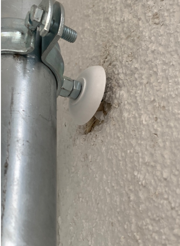
Abb. 3: Die Anschlüsse der Fixierung sind teilweise nicht fachgerecht beigearbeitet
