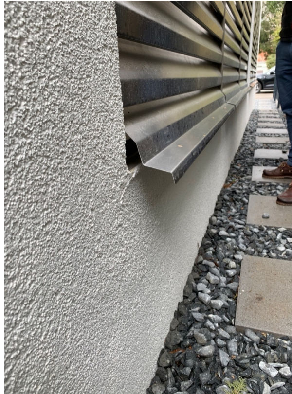
Abb. 13: Scharfkantige Bleche (Verletzungsgefahr)
