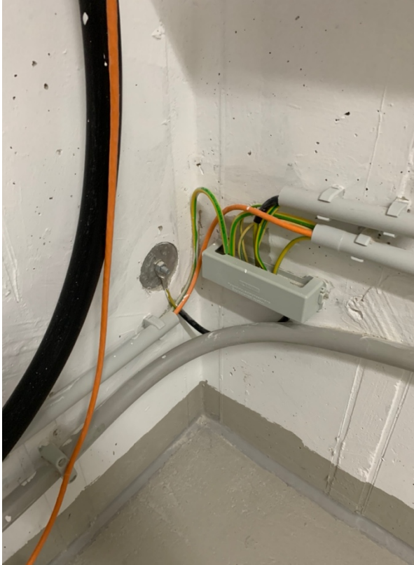
Abb. 42: PE-Leiter am Fundamenterder
