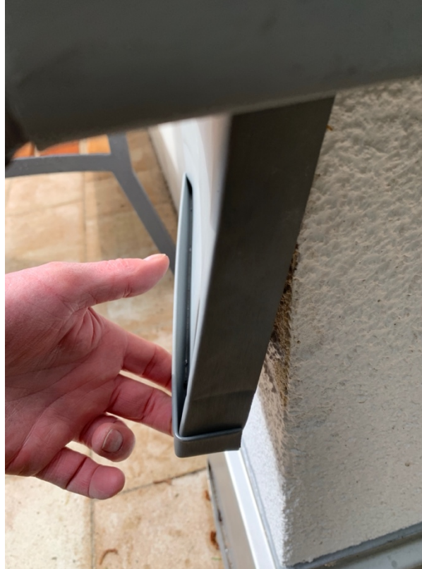
Abb. 22: Mangelhaft erstellte Verblendung
