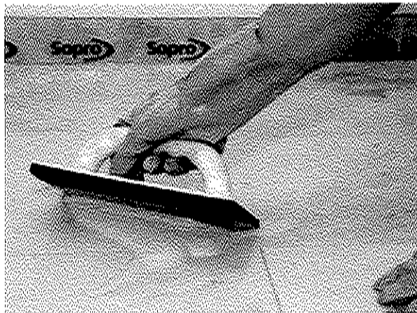
8 Einfugen von Sopro DF 10 in verarbeitungsempfindlichen Naturstein.
