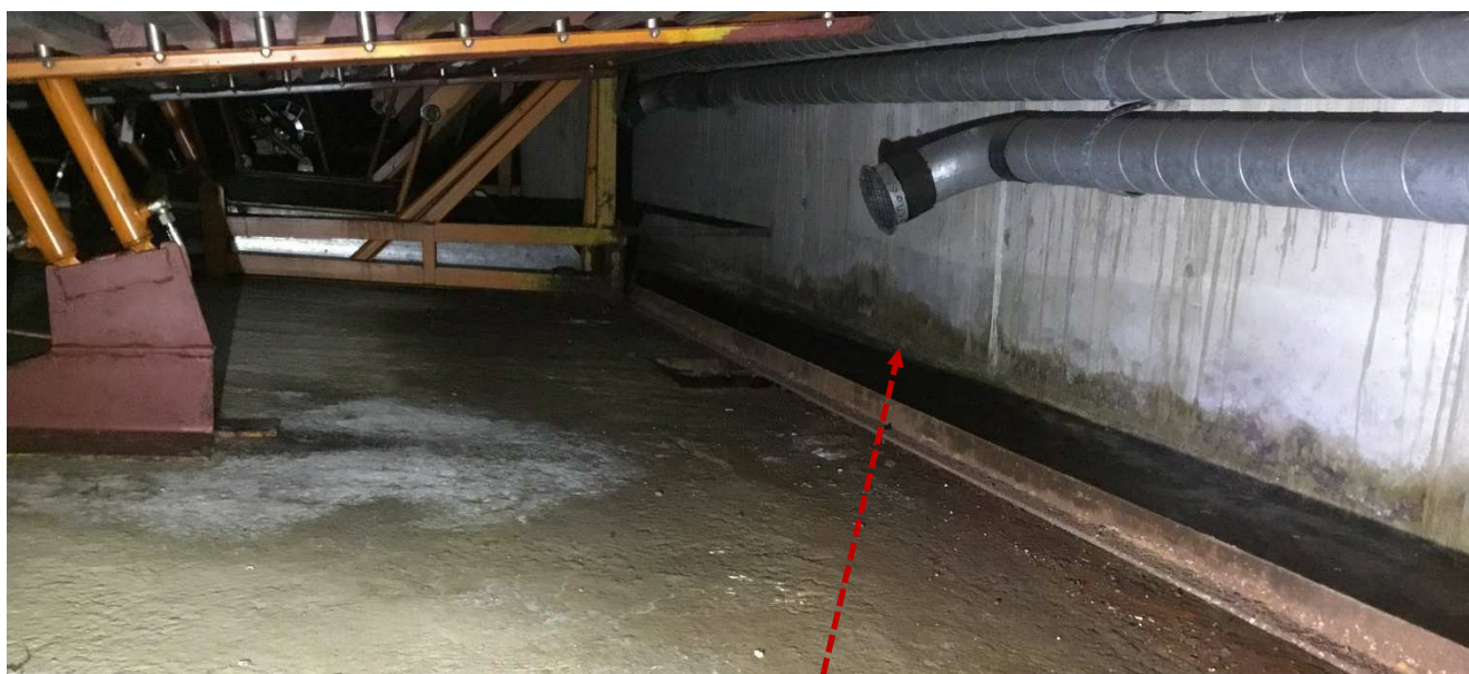
Abb. 20: Der unbeschichtete Stb.-Boden in der Doppelparkergrube ist mit einem deutlichen Quergefälle zur Tiefgaragenwand ausgebildet. Entlang der Stb.-Wand zur TG sind Feuchtränder im unteren Wandbereich festzustellen. Auf dem Boden sind partiell großflächige Chloridablagerungen vorhanden. Entwässerungseinrichtungen fehlen.
