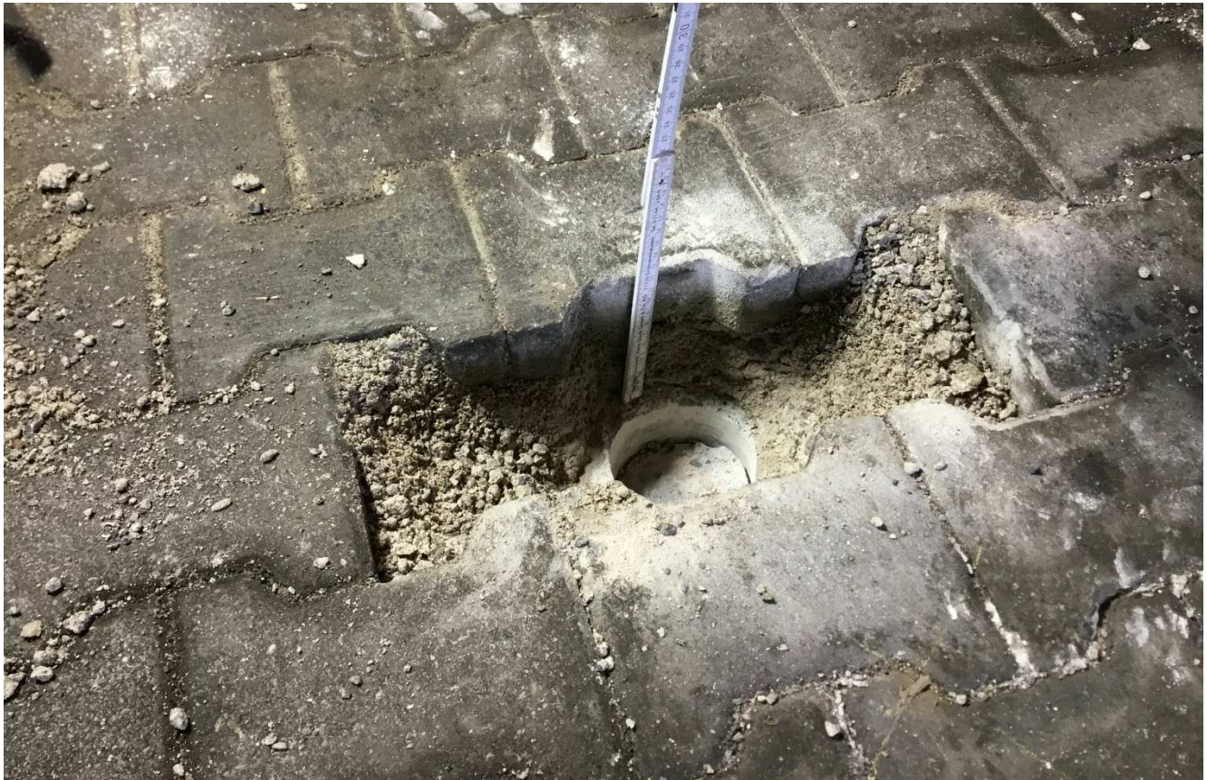
Abb. 18 Abb. 32: Blick auf die Bauteilöffnung und die Entnahmestelle des Bohrkerns in der Rampe. Der Betonsteinpflasterbelag ist im Mörtelbett direkt auf der Stb.-Rampe aufgebracht. Eine Abdichtung ist nicht vorhanden.
