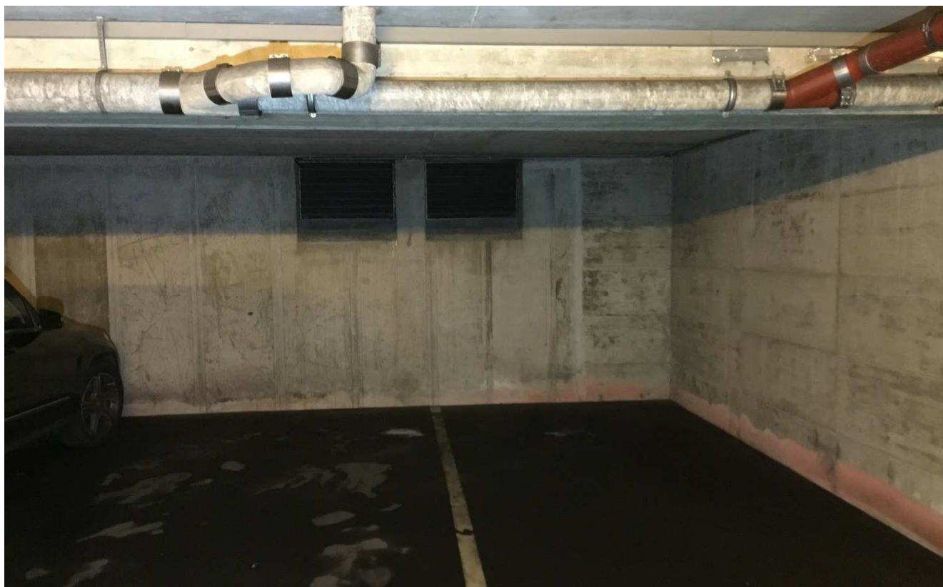
Abb. 22: Salzränder und Verfärbungen der Wandsockel im Bereich der Stellplätze Nr. 35 + 36.
