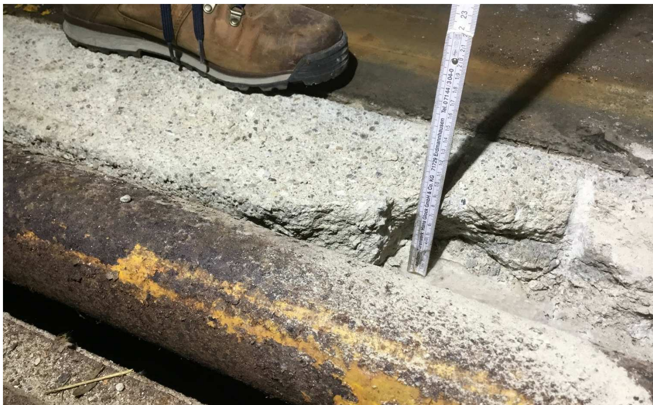
Abb. 15: Bauteilöffnung Nr. 33 [A] 6 am Übergang zu der Doppelparkergarbe. Die Dicke des Gefällestriches beträgt am Hochpunkt ca. 80 mm.
