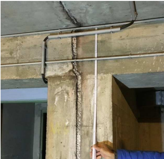
Abb. 26: Im Bereich der Bauteilfuge an Aufnahme B 24 [A] 6 sind Feuchteschäden infolge eines Wassereintritts über die TG-Decke vorhanden. Die Feuchteränder sind am 12.12.2016 sensorisch trocken.
