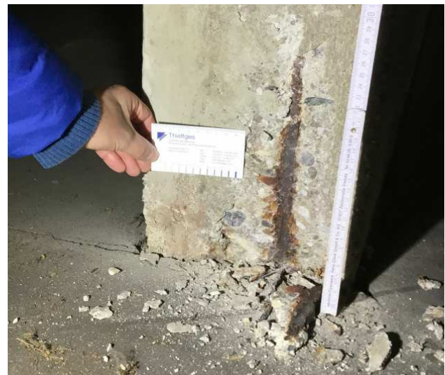
Abb. 25: Die Aufnahme B15 [A] 6 zeigt exemplarisch den charakteristischen Erhaltungszustand der korrodierten Bewehrung nach dem Freilegen im Sockelbereich am Wandkopf WS 10. Der Querschnittsverlust der Stützenbewehrung beträgt > 50 %.
