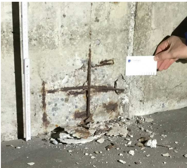
Abb. 24: Die Aufnahme B12 [A] 6 zeigt exemplarisch den charakteristischen Erhaltungszustand der korrodierten Bewehrung im Sockelbereich der Wand. Der Querschnittsverlust der Bügelbewehrung beträgt bis zu 100%. Die Betondeckung ist abgeplatzt.
