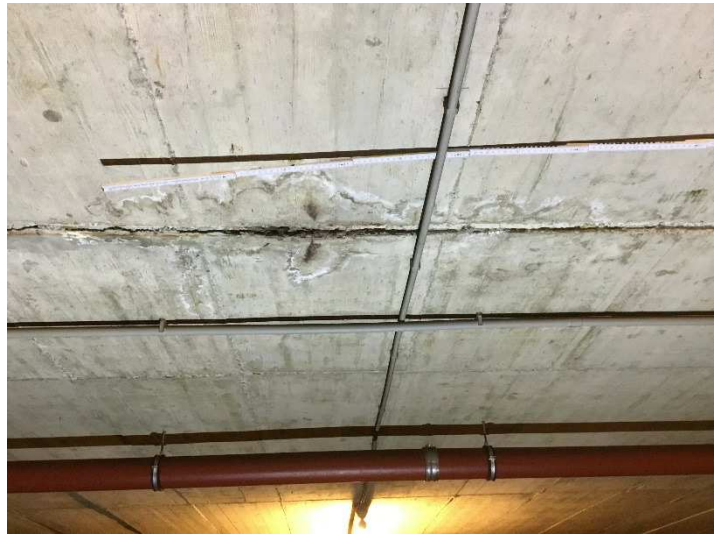
Abb. 27: Die Feuchteschäden setzen sich entlang der Decke fort (Aufnahme B 28, [A] 6).
