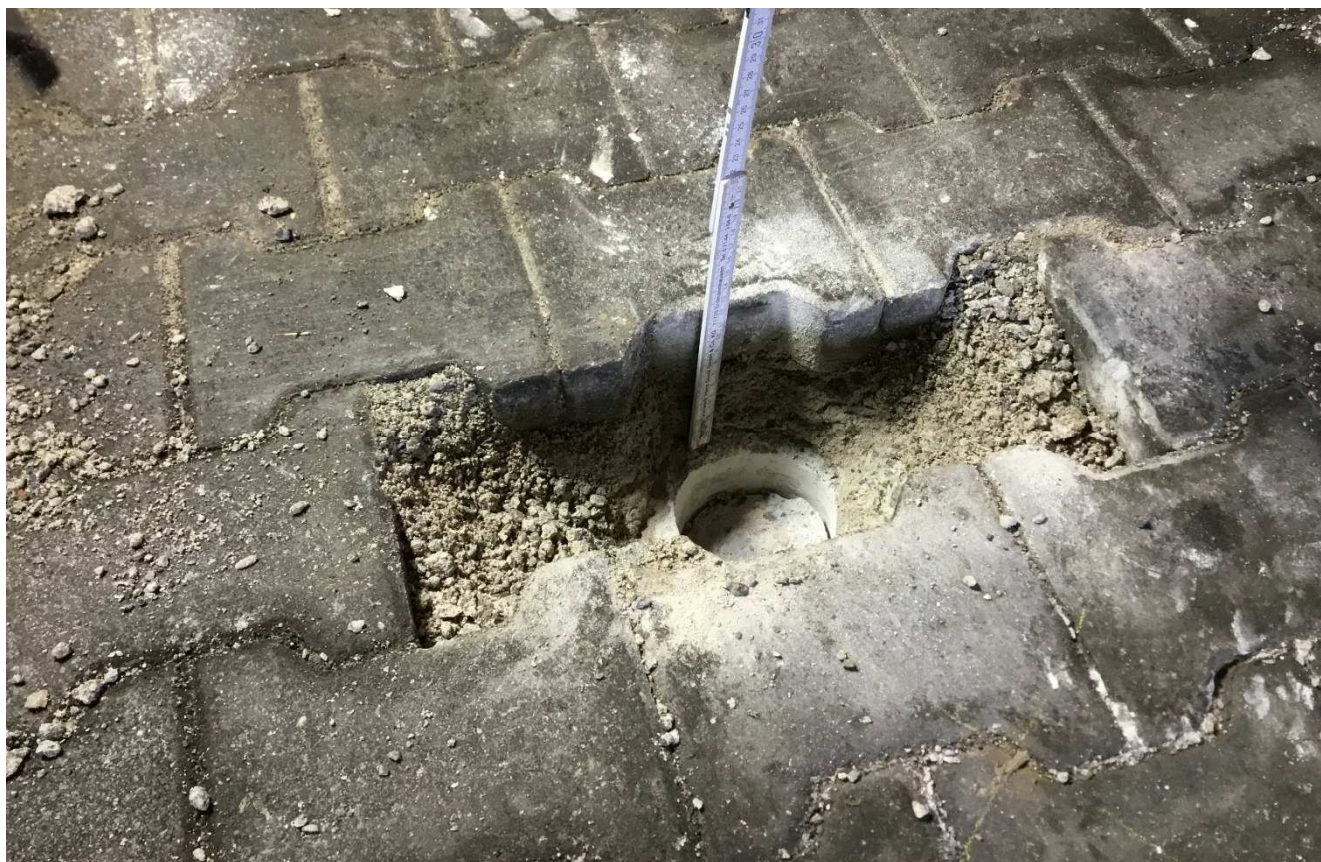
Abb. 18: Bauteilöffnung Nr. 03 im oberen Rampendrittel: Das 6 cm starke Betonpflaster ist in einem ca. 6 cm starken Mörtelbett verlegt. Auf der Stb.-Rampe ist keine Abdichtung vorhanden.
