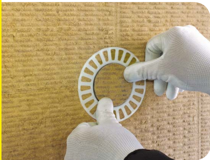
Dübelschema l | (4 Dübel pro m 2 )
