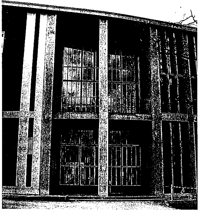
Südfassade der Matthäuskirche, Fensterpartie mit Sichtbetonrahmung (Foto: Harald Gieß)
